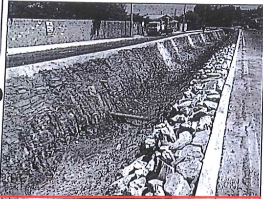
Foto 7: Ilustra a rede interceptora objeto desta perícia sendo interligada na rede interceptora já existente.
