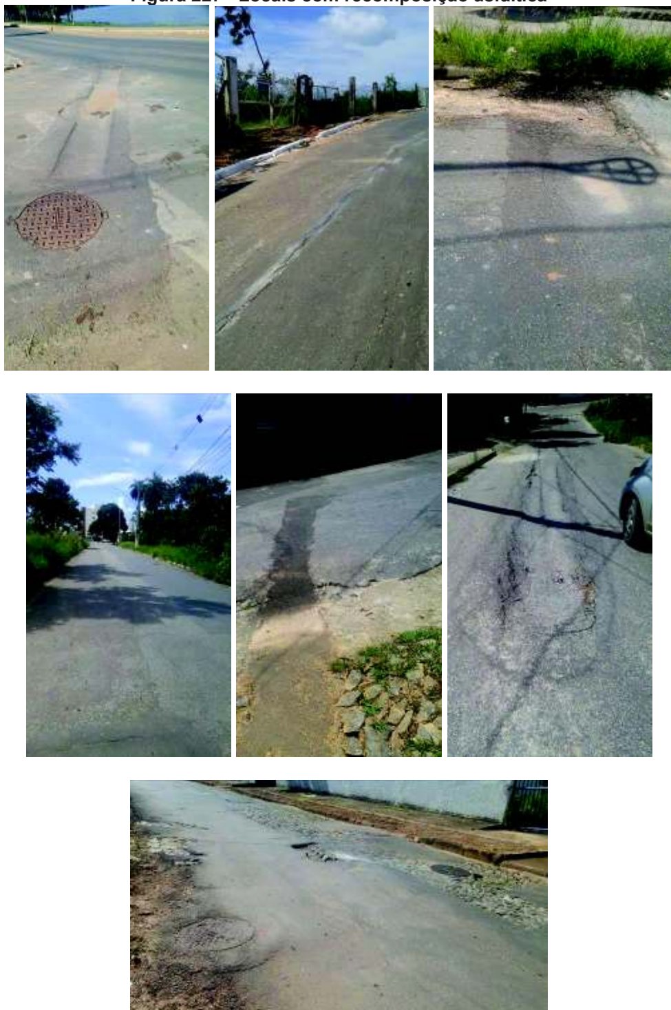
Figura 227 - Locais com recomposição asfáltica
