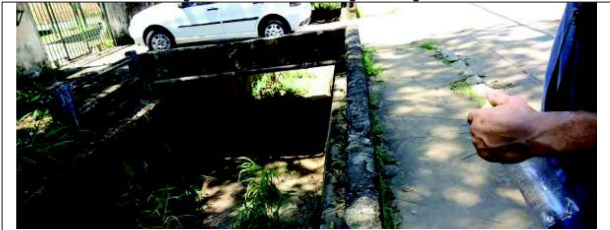
a- Vista geral do canal.
