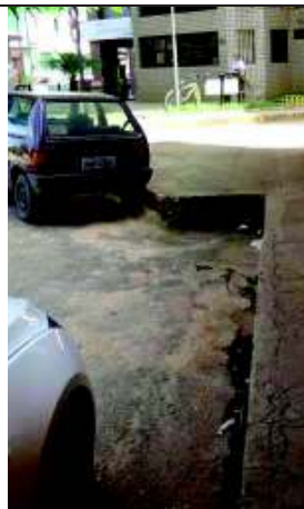
d- Ponto de captação, P41, (R. Ouro Preto).
