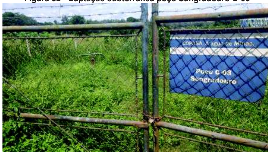
Figura 62 - Captação subterrânea poço Sangradouro C-03
