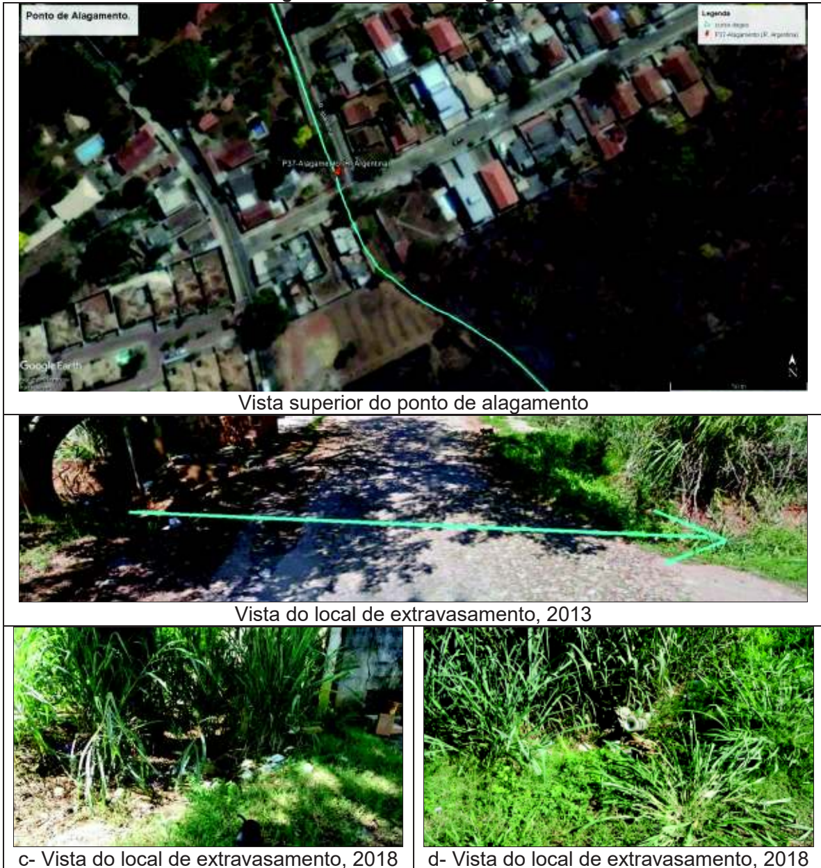
Figura 136 - Ponto de alagamento
