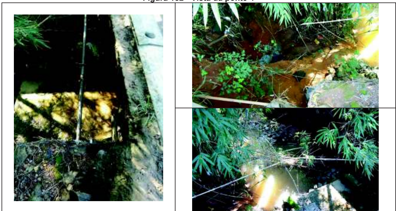
Figura 182 - Vista da ponte 4
