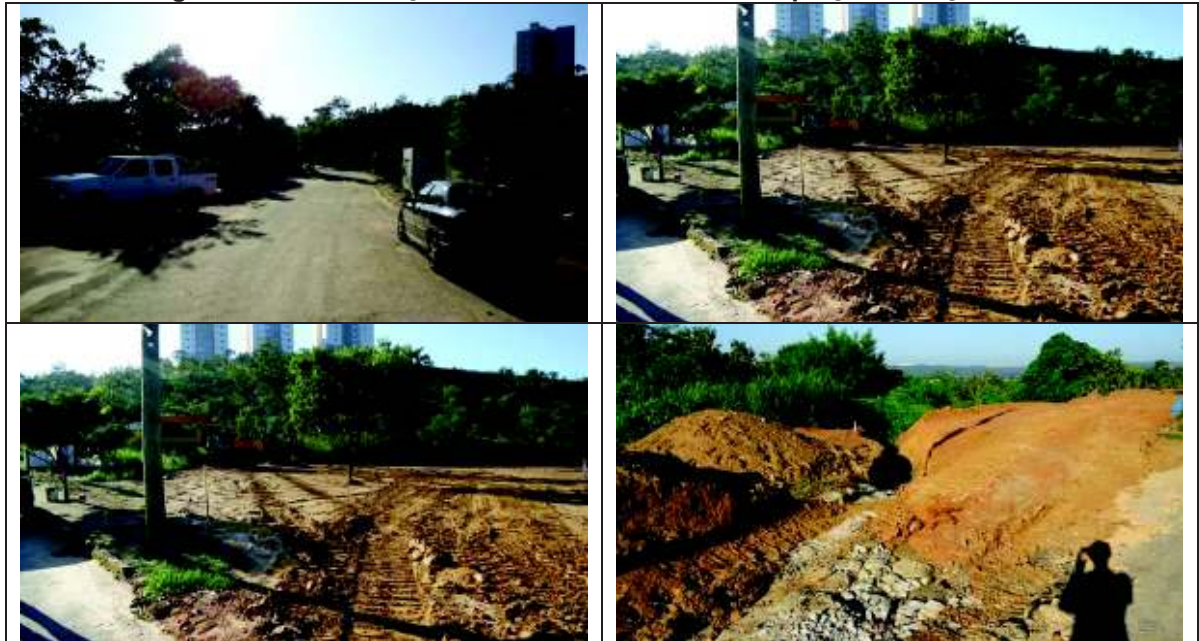
Figura 164 - Construção de um novo sistema de captação e lançamento
