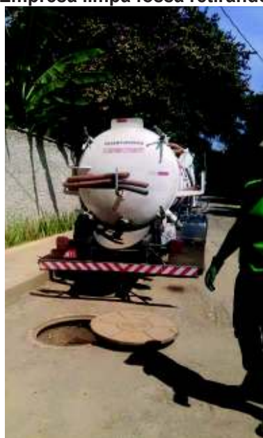
Figura 75 - Empresa limpa fossa retirando os esgotos
