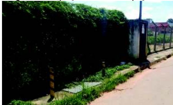
Figura 41 - Captação subterrânea poço C-13
