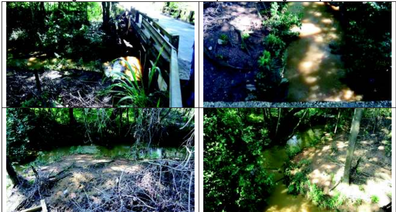
Figura 196 - Vista da Ponte 2 e seu corpo hídrico (córrego do Jaque).
