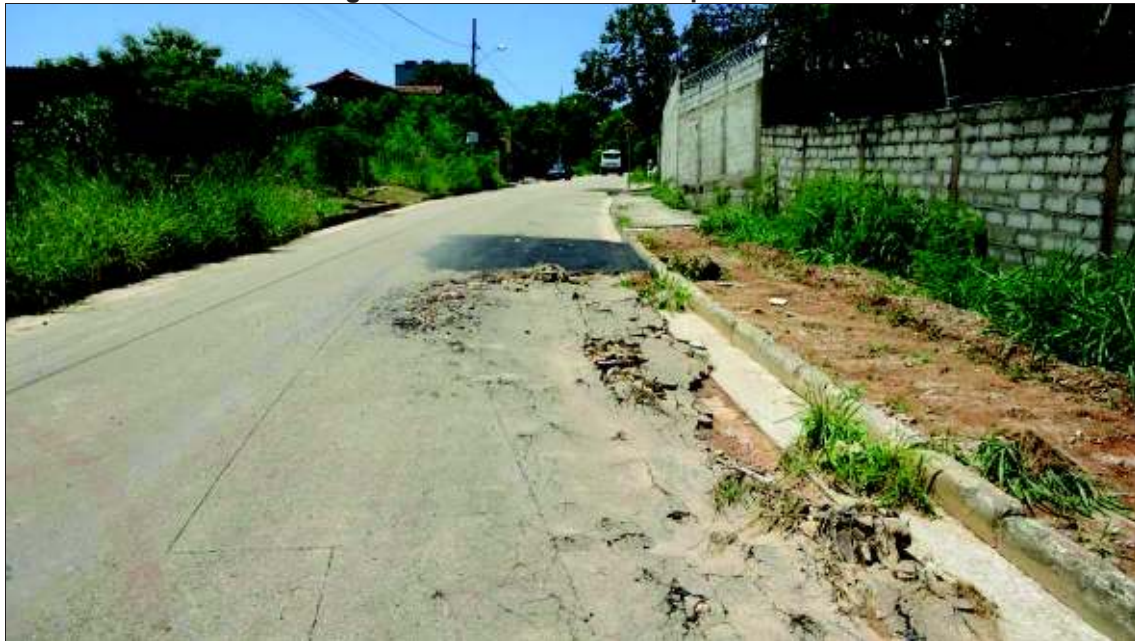
Figura 121 - Carreamento do pavimento
