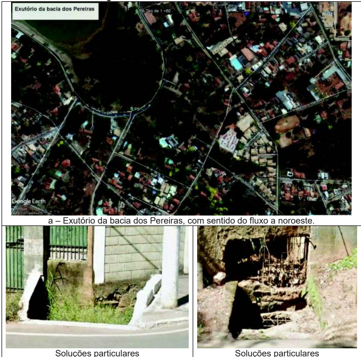
Figura 140 - Exutório da bacia dos Pereiras
