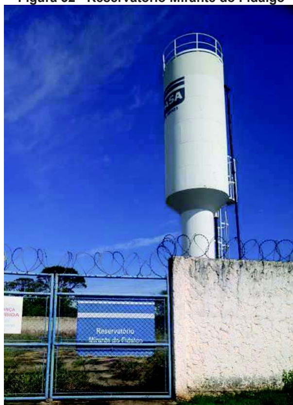
Figura 32 - Reservatório Mirante do Fidalgo
