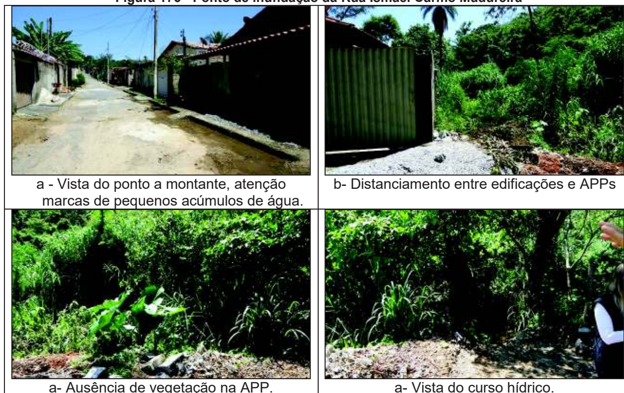
Figura 176 - Ponto de inundação da Rua Ismael Carmo Madureira
