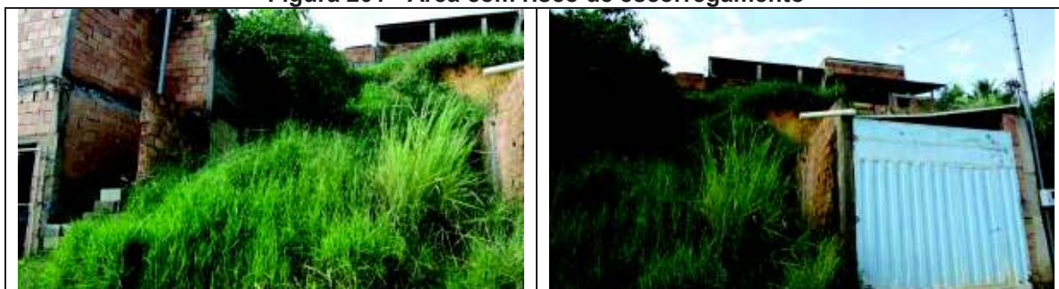
Figura 201 - Área com risco de escorregamento
