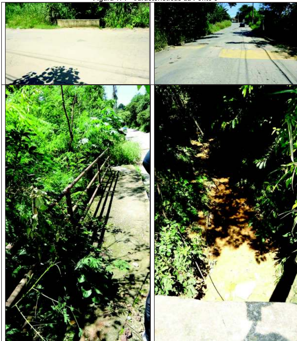
Figura 174 - Características da Ponte 5
