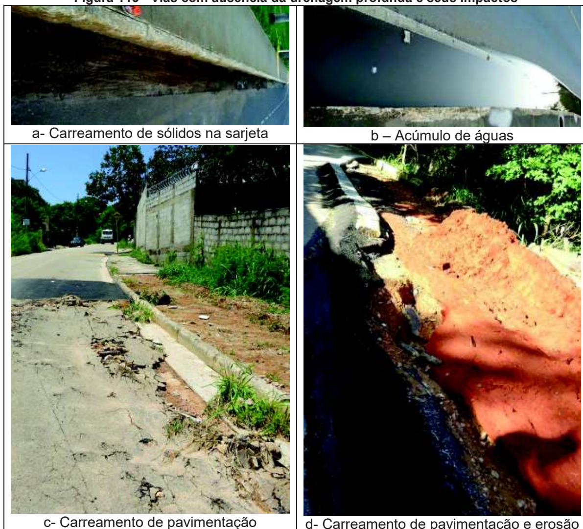
Figura 113 - Vias com ausência da drenagem profunda e seus impactos
