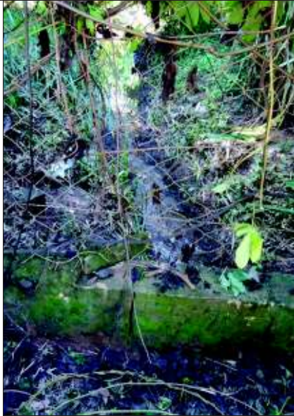
a – Curso natural a jusante da estrutura de condução.
