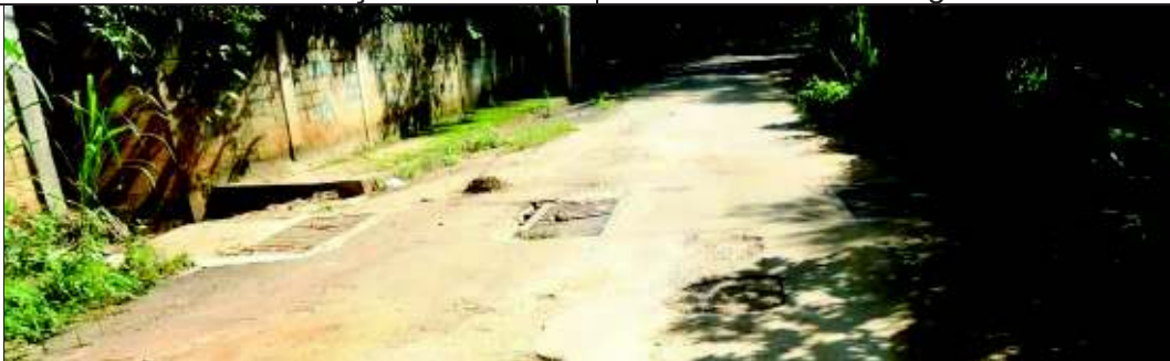
c- Vista da estrutura de drenagem e as bocas de captação das águas superficiais
