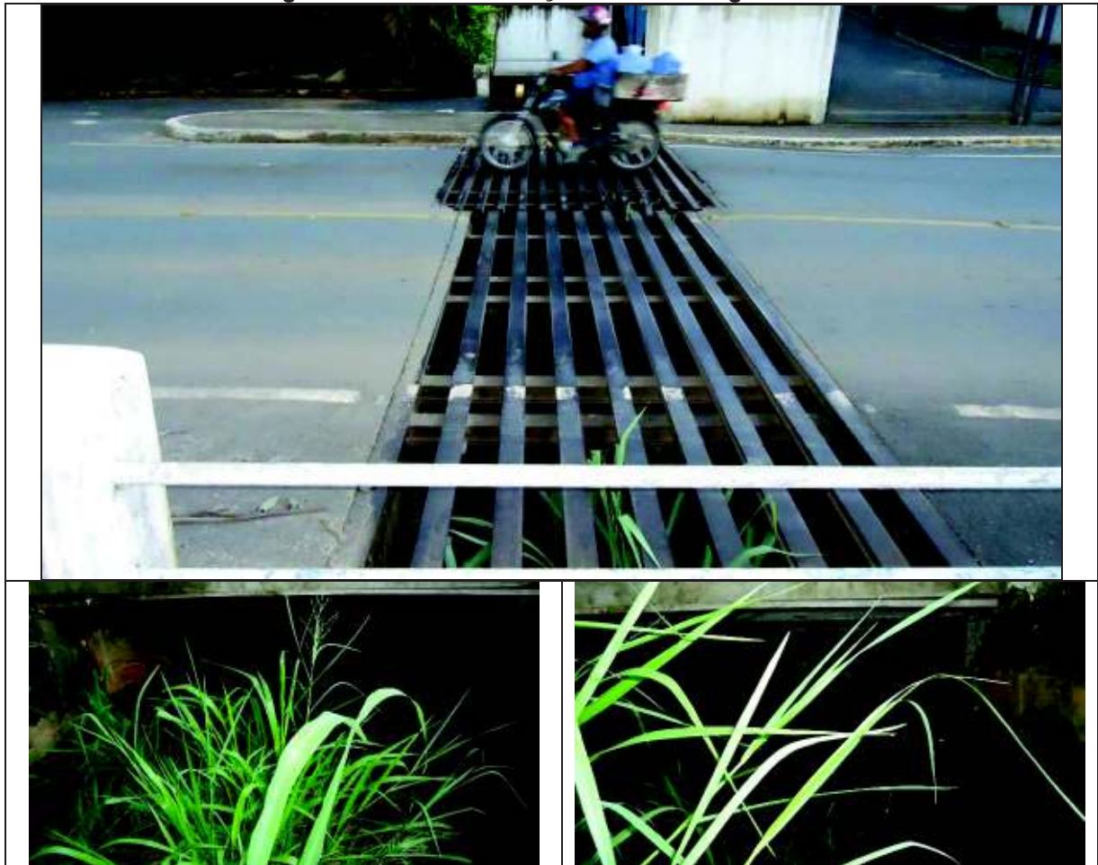
Figura 169 - Canal de lançamento dos Engenheiros
