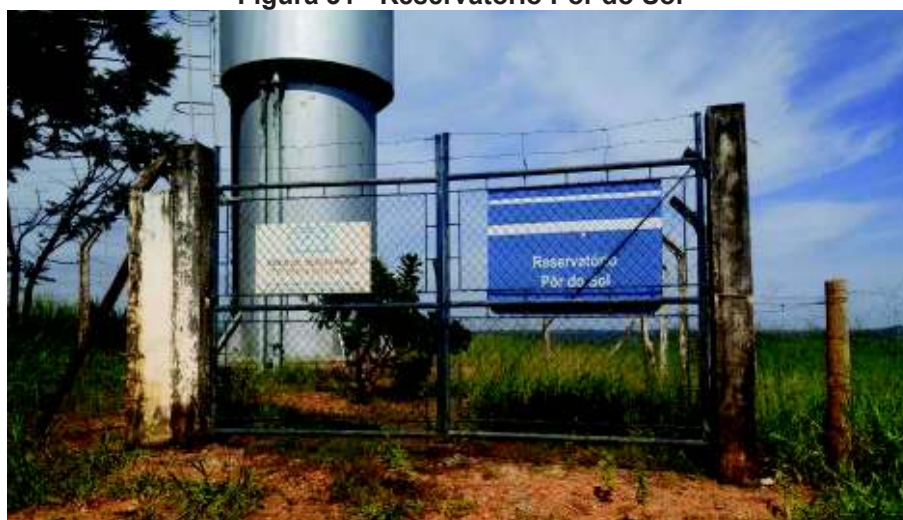
Figura 31 - Reservatório Pôr do Sol
