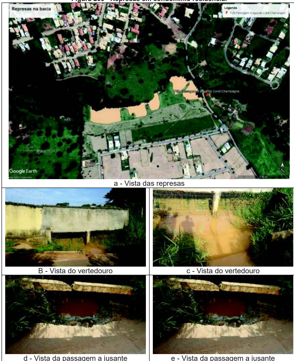
Figura 200 - Represas em condomínio residencial
