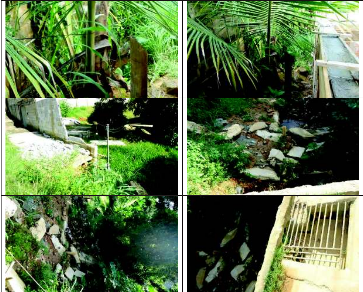
Figura 199 - Ocupações de fundo de vale em região com histórico de inundação
