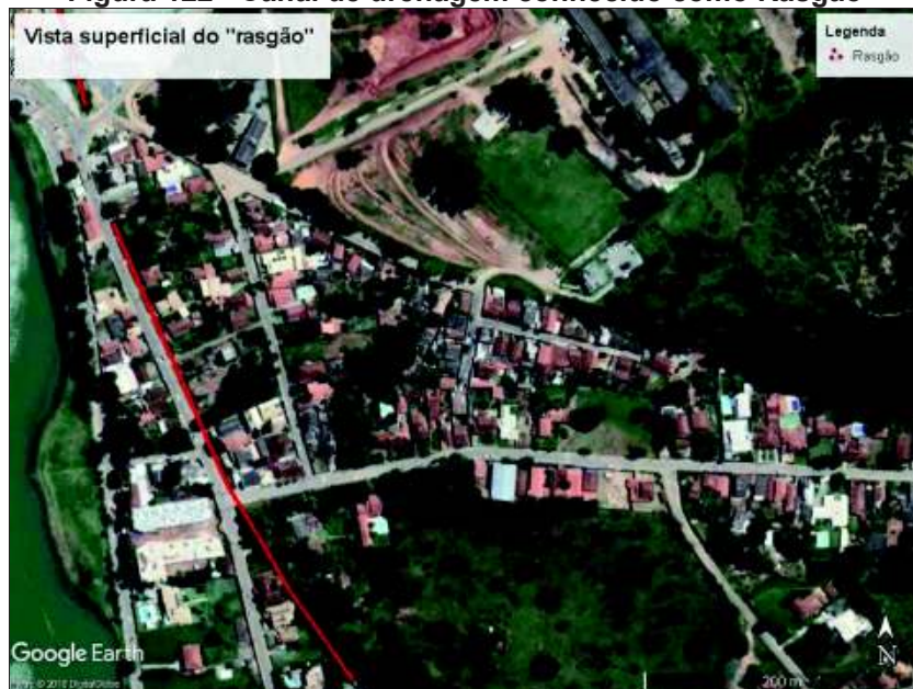
Figura 122 - Canal de drenagem conhecido como Rasgão
