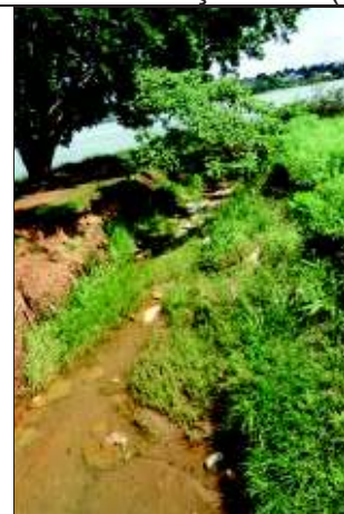
e- Jusante do ponto de lançamento, com erosão.
