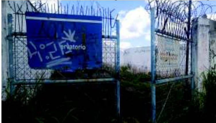
Figura 47 - Reservatório Lagoa Mansões
