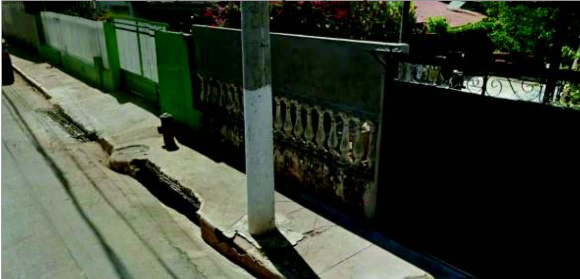
Figura 151 - Captação da drenagem e passagem abaixo do imóvel
