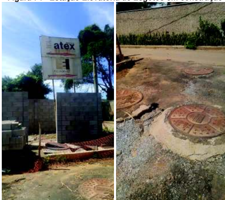
Figura 74 - Estação Elevatória de Esgotos em construção
