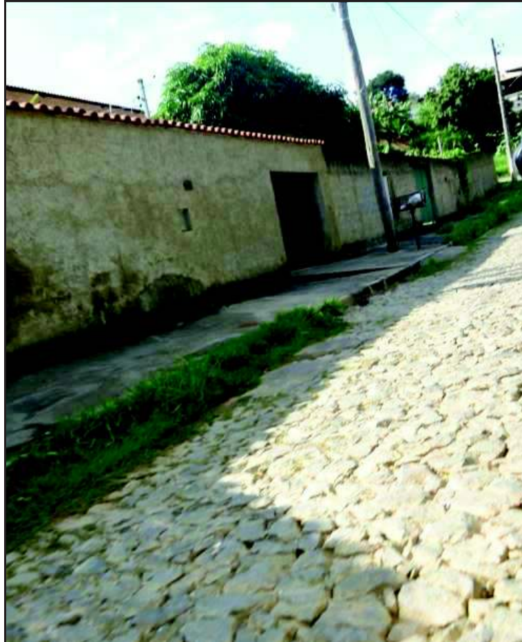
Figura 135 - Vista geral de vias da bacia dos Pereiras
