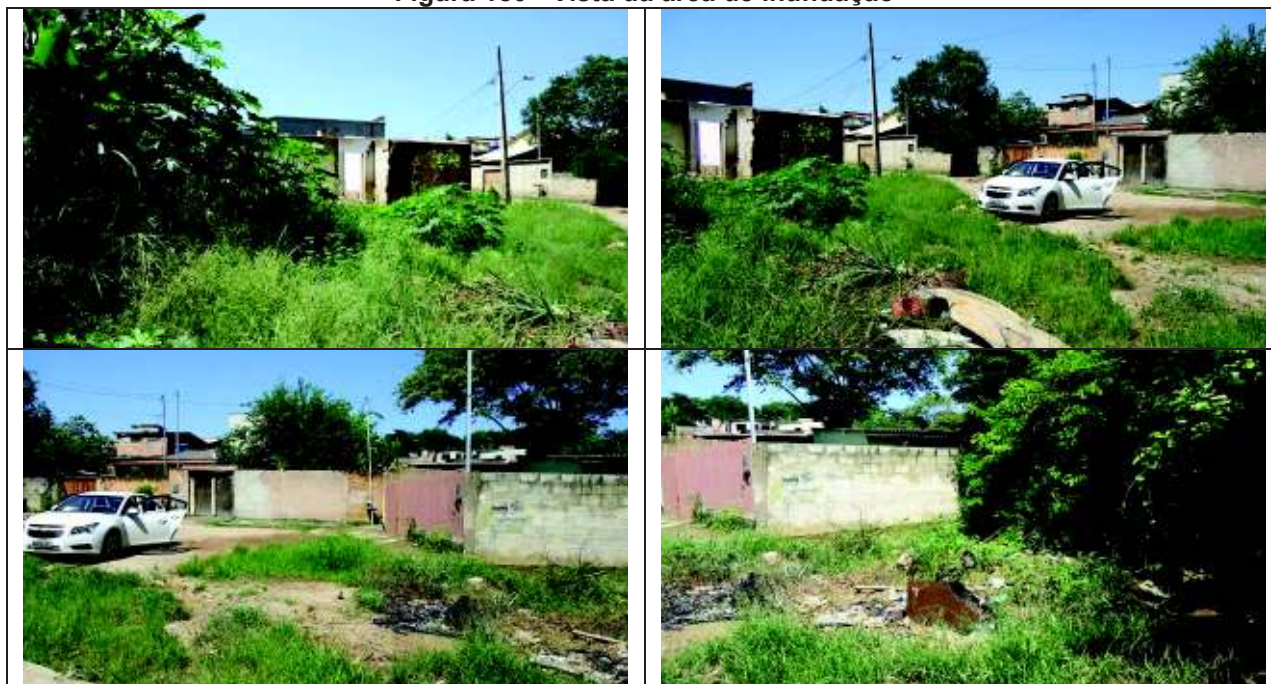
Figura 180 - Vista da área de inundação
