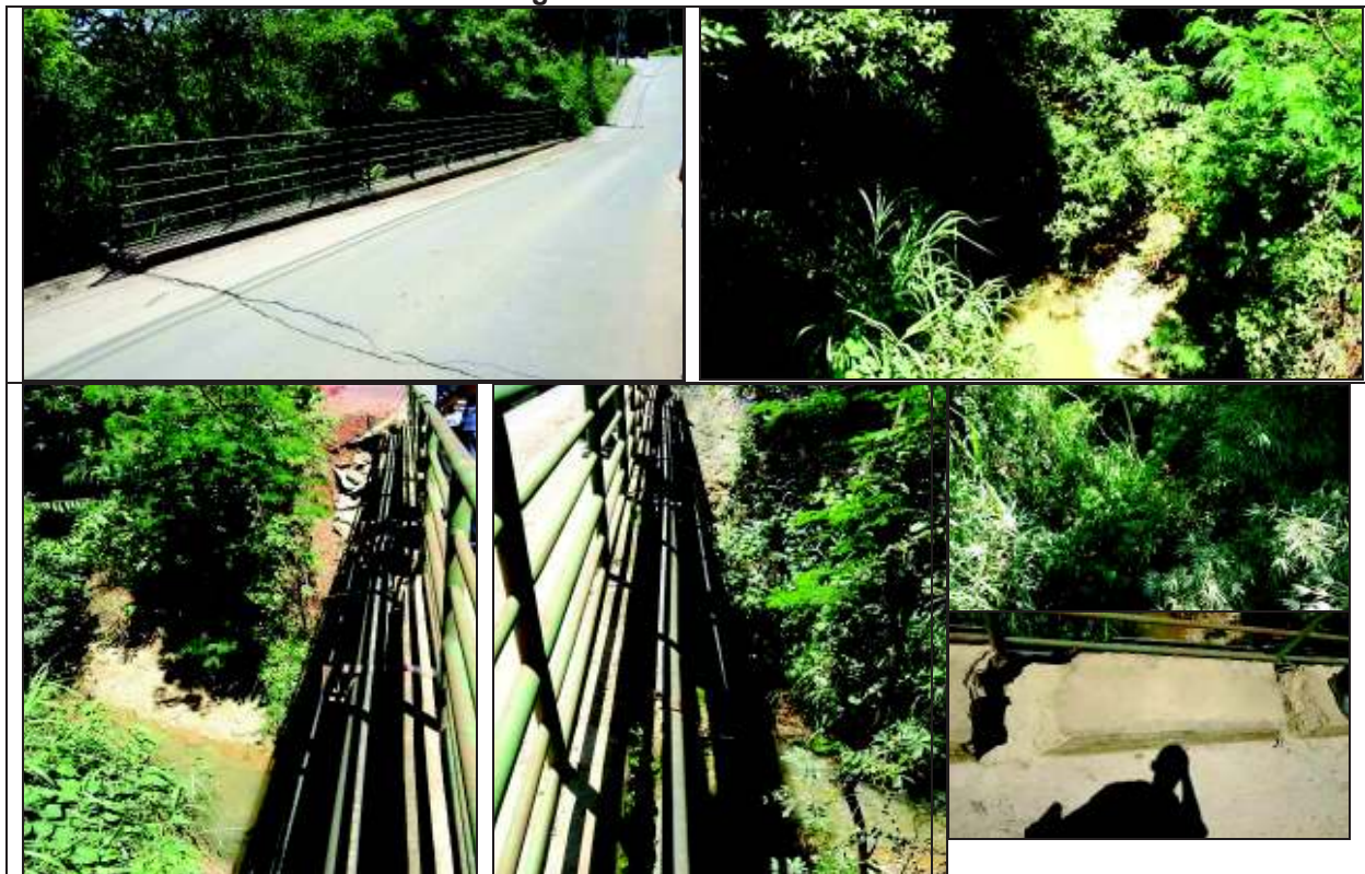
Figura 178 - Vista da Ponte 3
