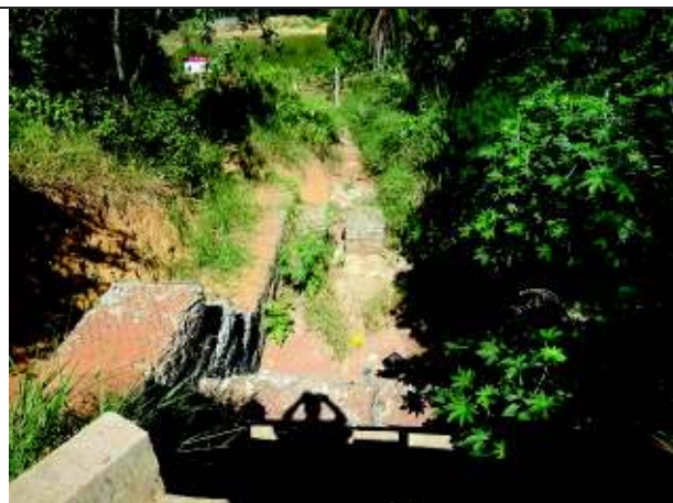
e – Escada de dissipação
