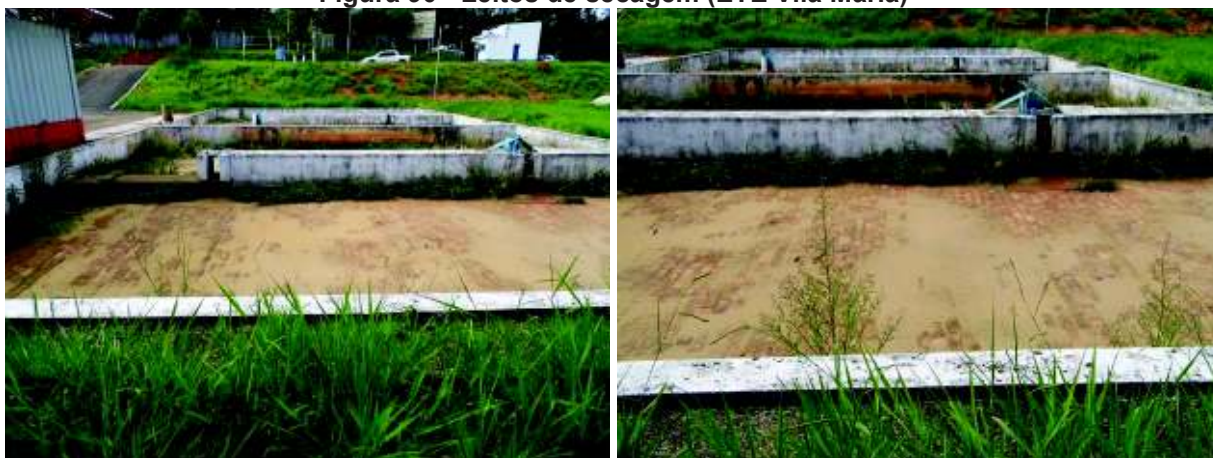
Figura 90 - Leitões de secagem (ETE Vila Maria)
