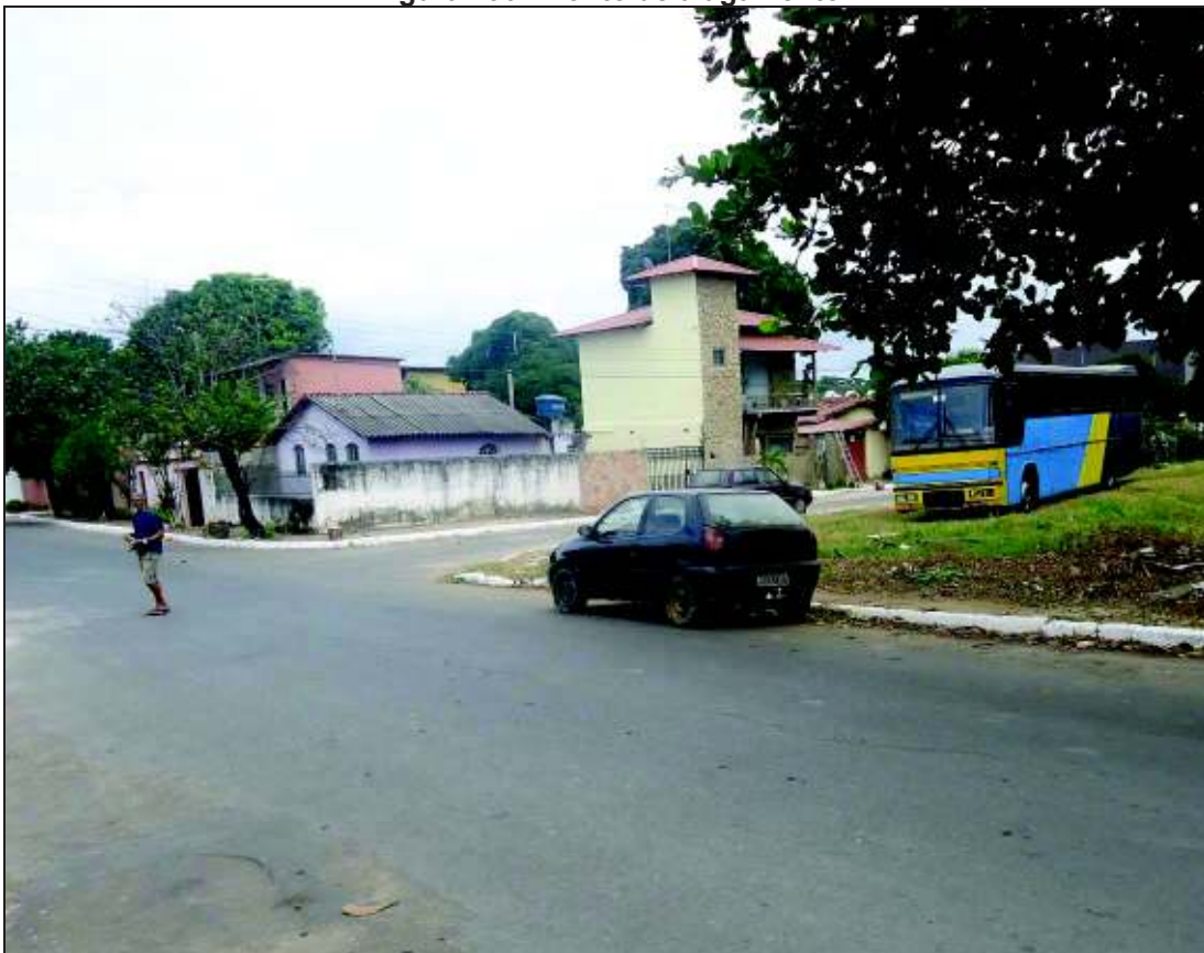
Figura 190 - Ponto de alagamento
