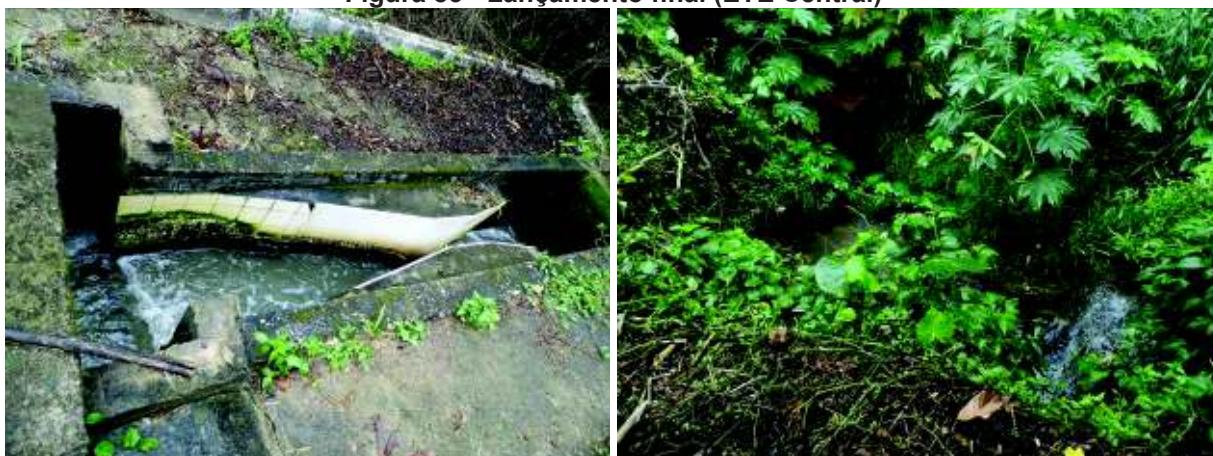
Figura 83 - Lançamento final (ETE Central)
