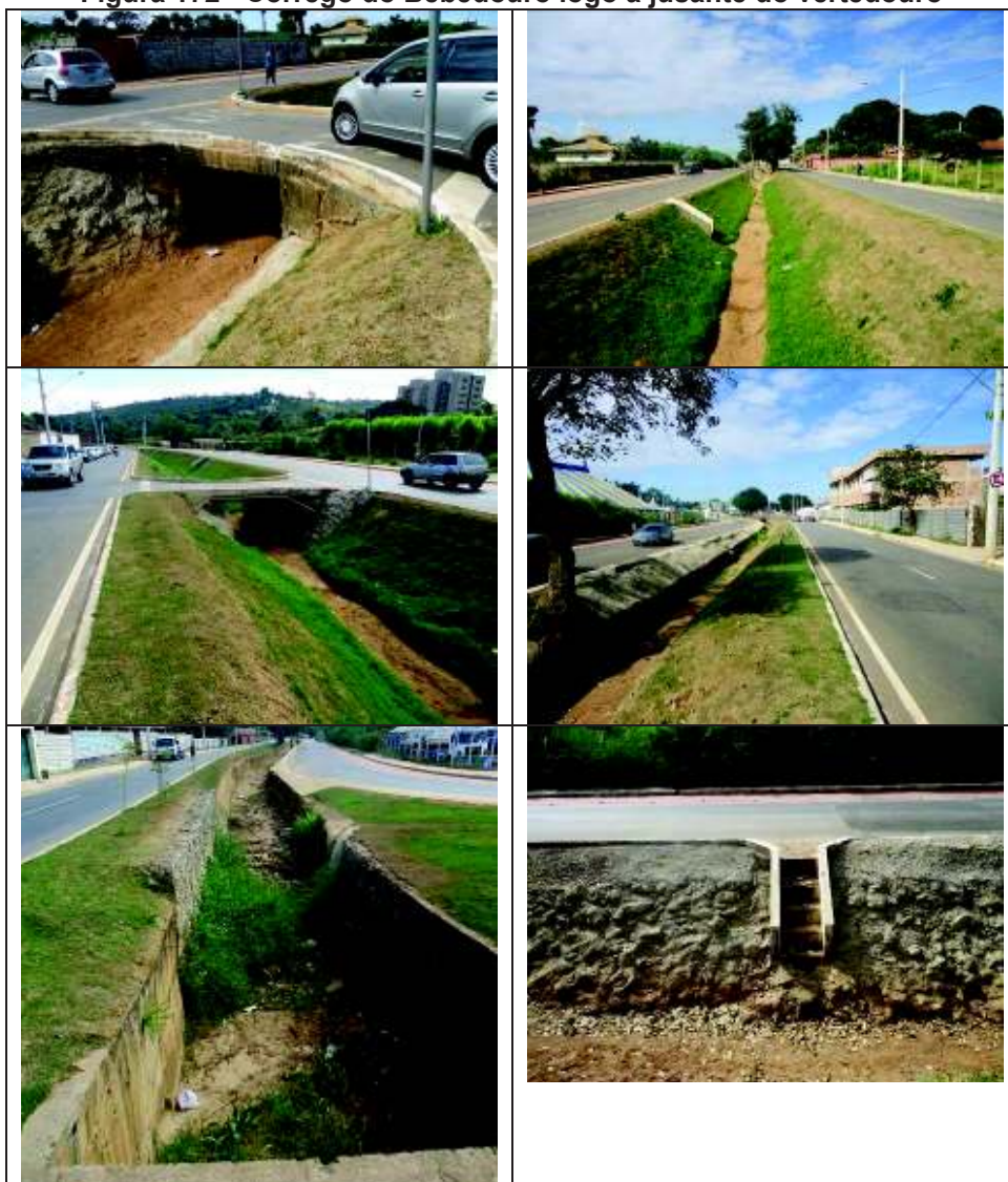
Figura 172 - Córrego do Bebedouro logo a jusante do vertedouro
