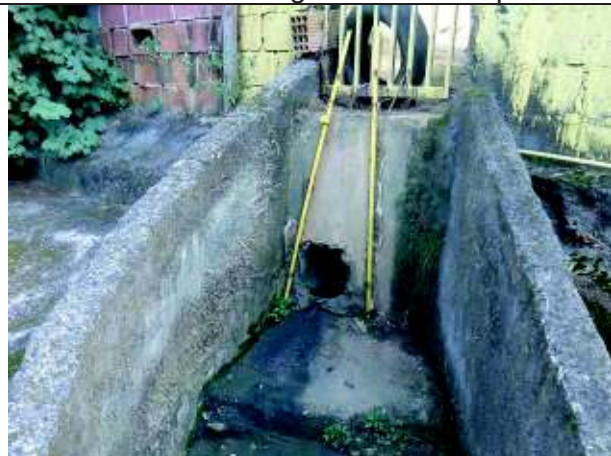
c- Lançamento no canal
