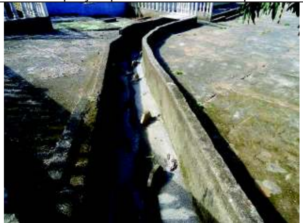
d- Canal com pequenas estruturas dissipadores.
