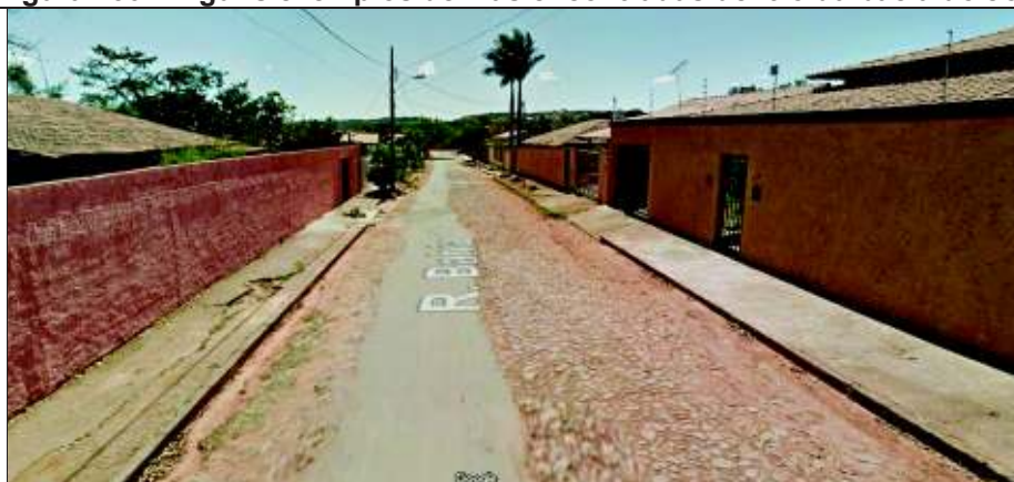
a- Exemplo de via pavimentada com a estrutura mínima de drenagem (sargeta).
