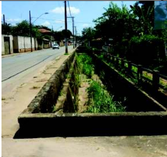
b- Vista geral do canal, assoreado.
