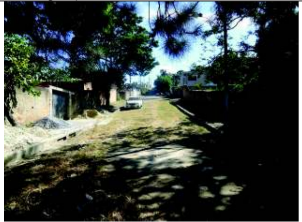
b- Captação profunda – Rua Aeroporto
