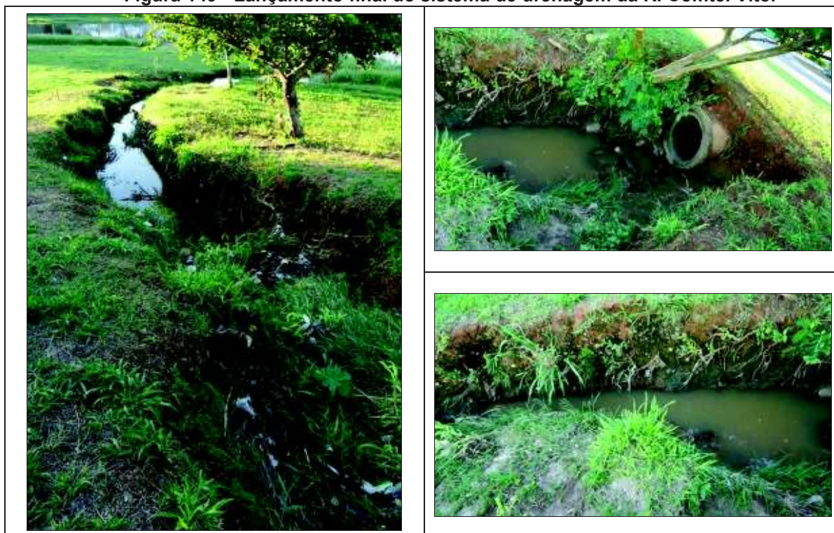
Figura 149 - Lançamento final do sistema de drenagem da R. Comte. Vitor
