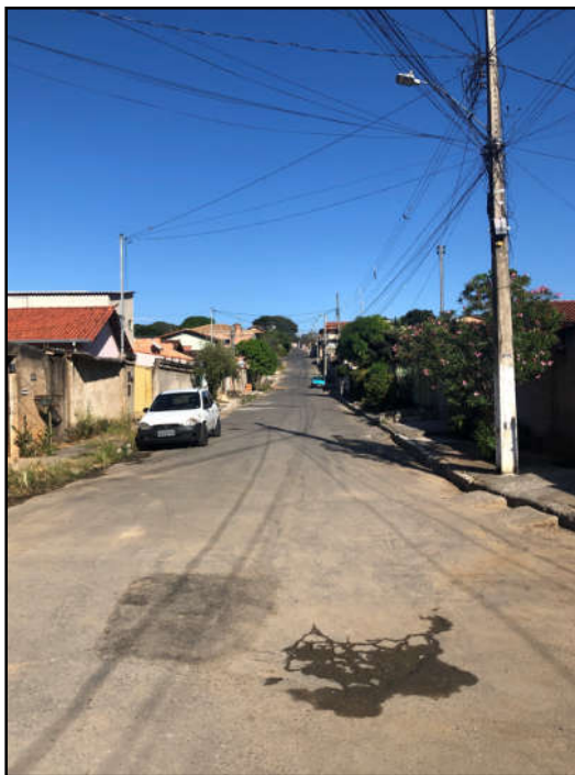
Figura 2 – Caracterização da área de intervenção para drenagem e recapeamento na Rua Amador Lopes de Souza. Fonte: Arquivo DMA
