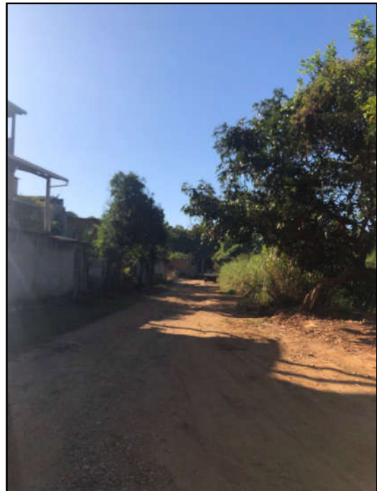
Figura 3 – Caracterização da área de intervenção para pavimentação na Avenida Sanitária. Fonte: Arquivo DMA
