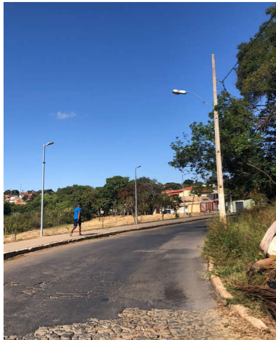
Figura 3 – Caracterização da área de intervenção para drenagem e recapeamento, Murilo Mendes. Fonte: Arquivo DMA
