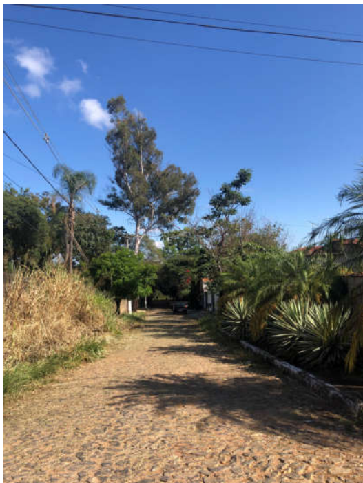
Figura 2 – Caracterização da área de intervenção para recapeamento. Fonte: Arquivo DMA
