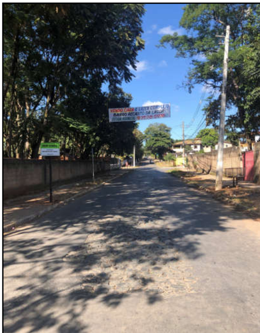
Figura 2 – Caracterização da área de intervenção para drenagem e recapeamento na Rua Joaquina de Paula Corrêa. Fonte: Arquivo DMA
