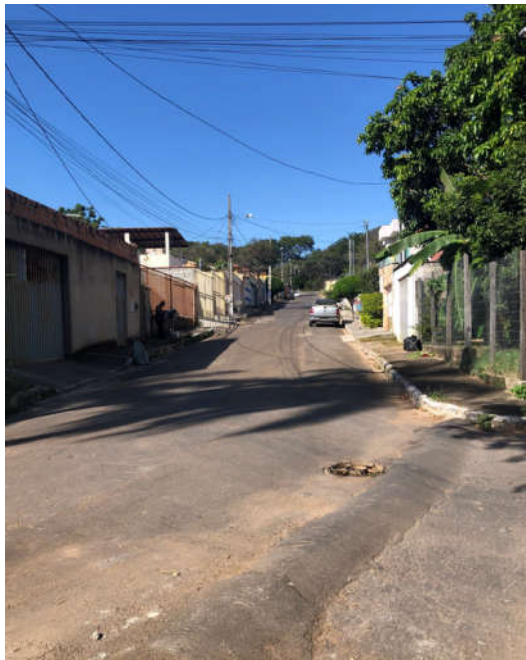
Figura 2 – Caracterização da área de intervenção para drenagem e recapeamento, na Rua Quintino Bocaiúva. Fonte: Arquivo DMA
