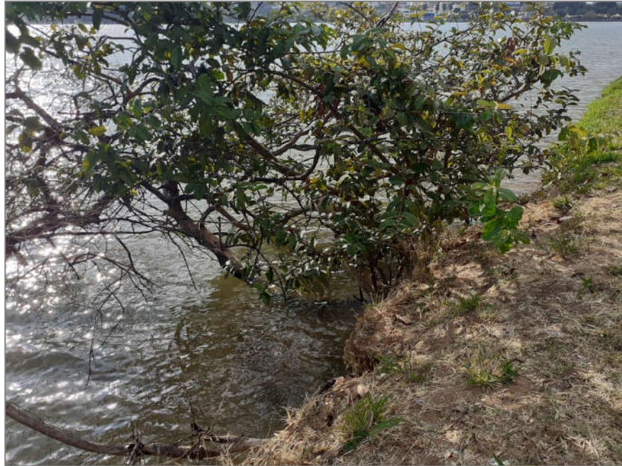
Figura 3 - Caracterização da vegetação passível de supressão para a implantação das obras de enrocamento. Fonte: Arquivo DMA
